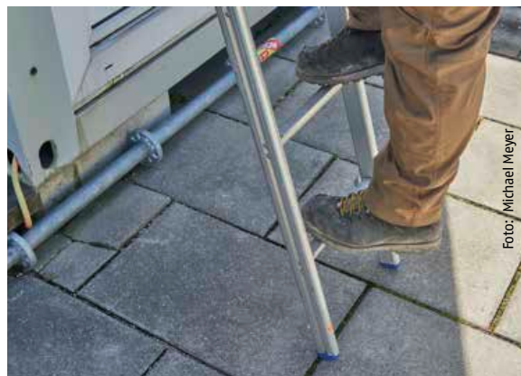
Flop ↘ Trittsicherheit auf engen Sprossen
