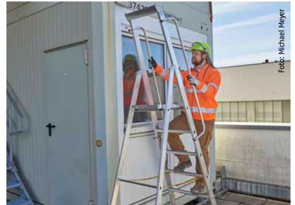
Top ↗ Sicherer Auf- und Abstieg mit standfester Stehleiter
