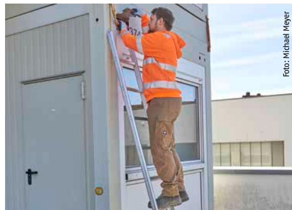
Flop ↘ Wackliges Arbeiten auf Sprossenleiter
